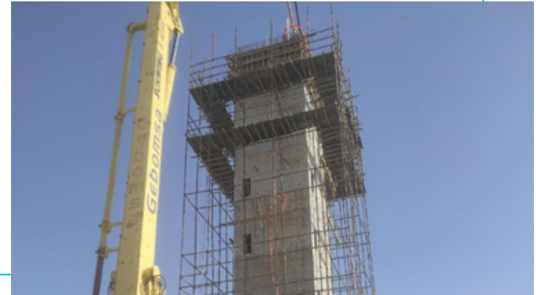
إنشاء برج تخزين المياه في مركز الغويري
