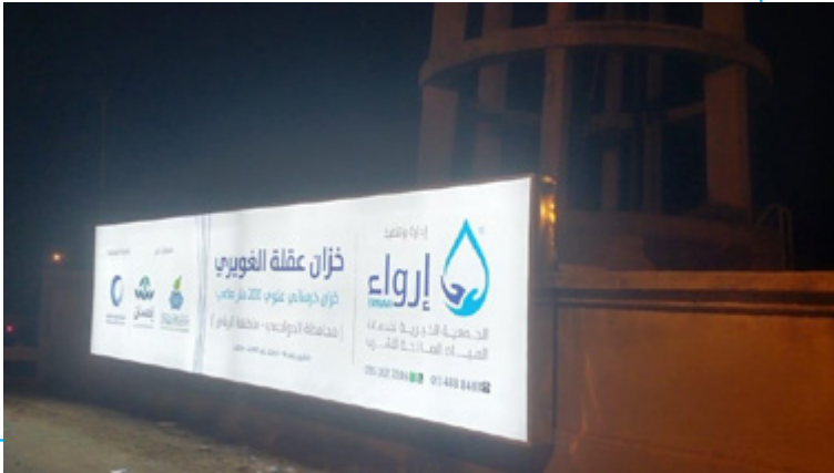
إنشاء برج تخزين المياه في مركز الغويري
